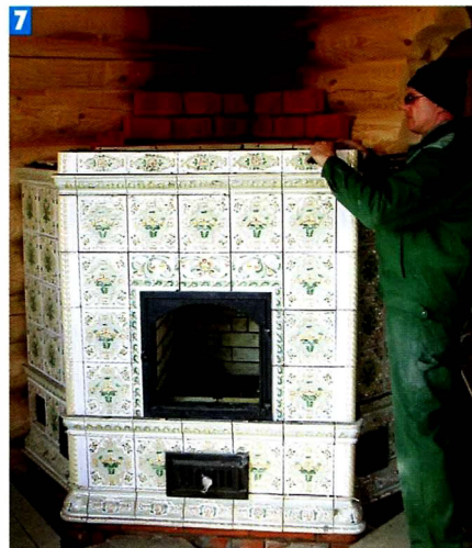
Изразцы устанавливают параллельно с кладкой массива печи.
