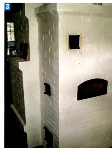
3 Эта печь-камин построена из качественного кирпича и покрашена без оштукатуривания...
