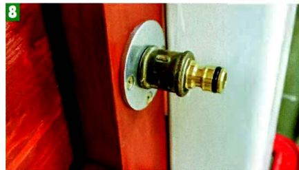
8 Металлический соединитель при подключении к подводящей трубе позволяет катушке вращаться, не нарушая герметичности.
